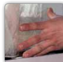
Verklebung unter Fensterleisten
